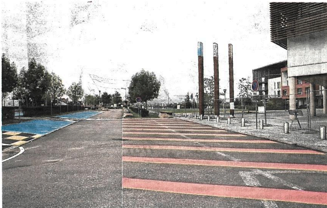
Une zone de dépose minute a été créée devant l'entrée principale du centre hospitalier. Elle s'accompagne de quinze places pour handicapés et deux places pour les taxis. Photo Bruno GRANDJEAN
