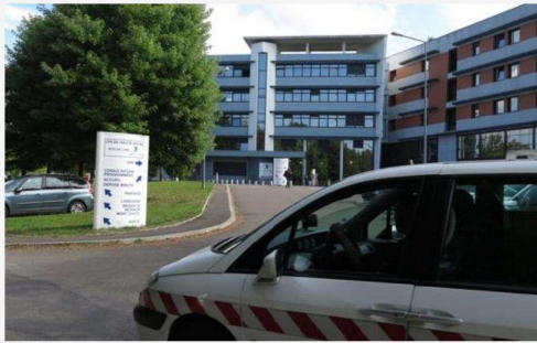
L'accès au chantier se fera par l'arrière du bâtiment, aussi il y a nécessité de créer des routes. Photo d'archives.
